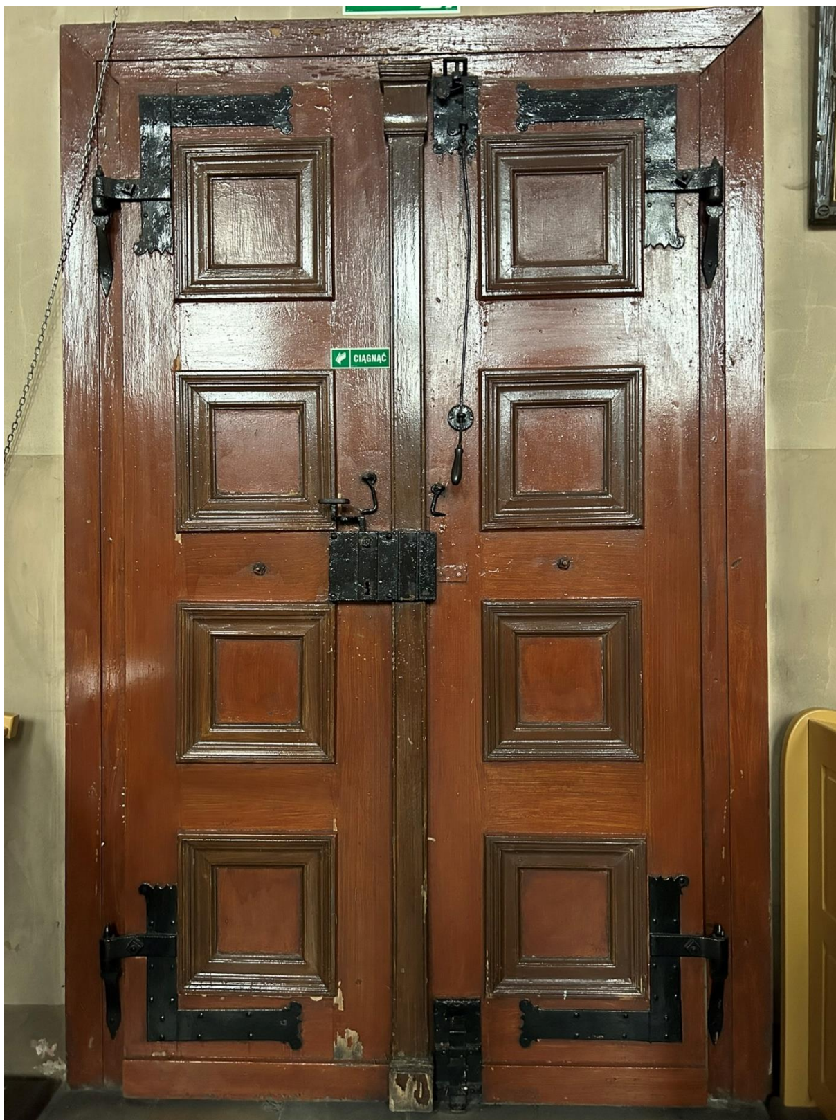
Drzwi do kruchty południowej
