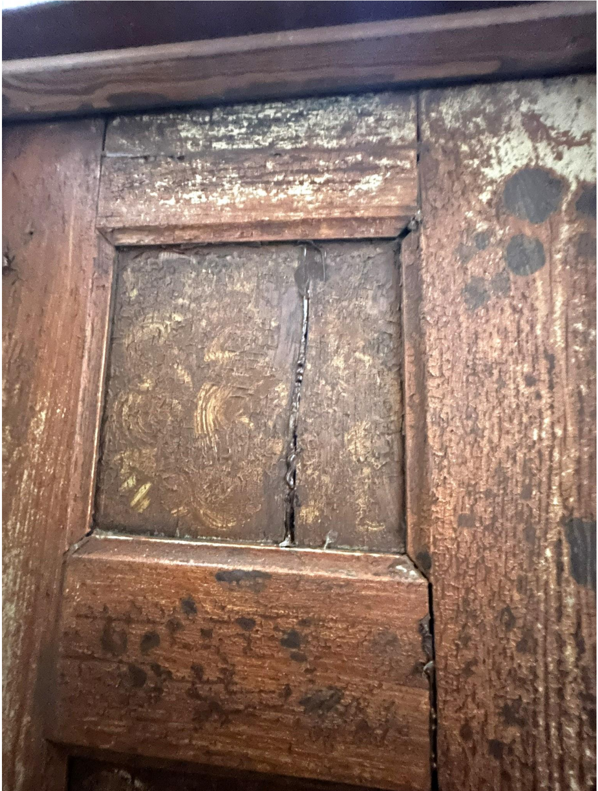
Wtórny mazerunek i pęknięcie płyciny
