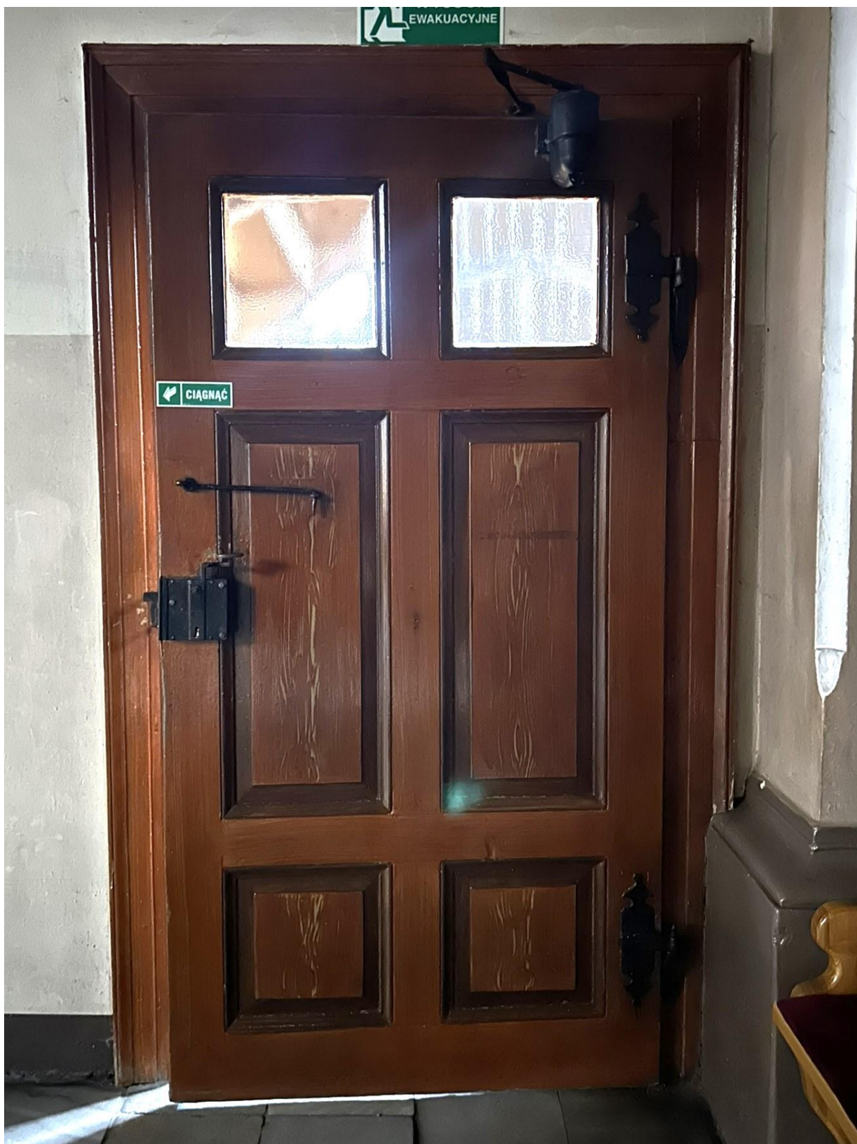
Drzwi z nawy na klatkę schodową od strony południowej
