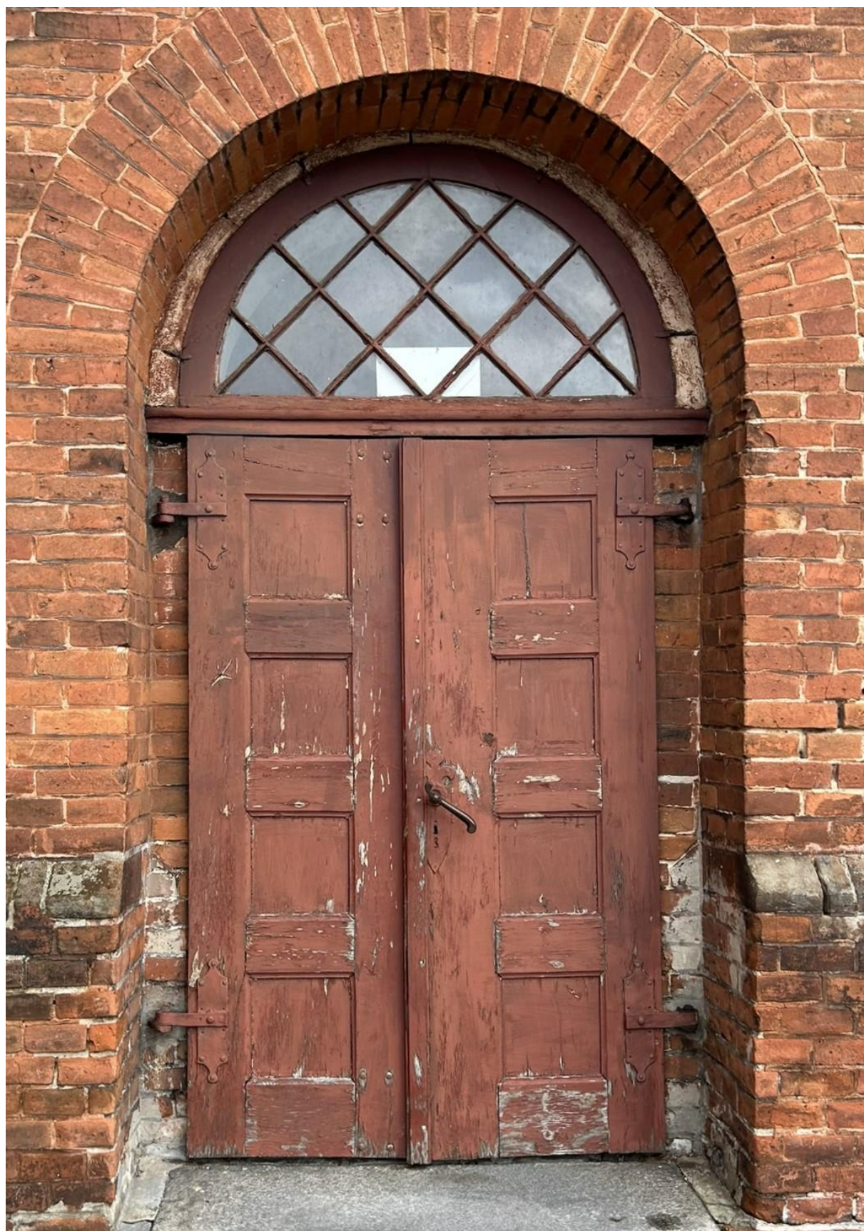
Drzwi boczne od strony zachodniej
