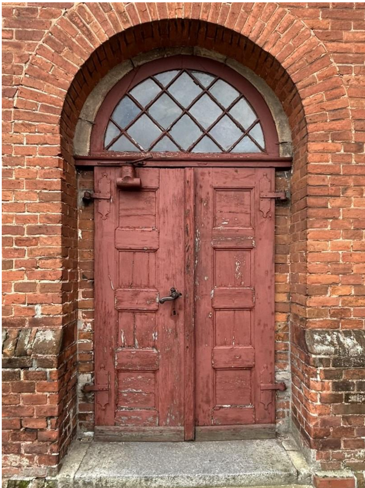
Drzwi boczne od strony zachodniej
