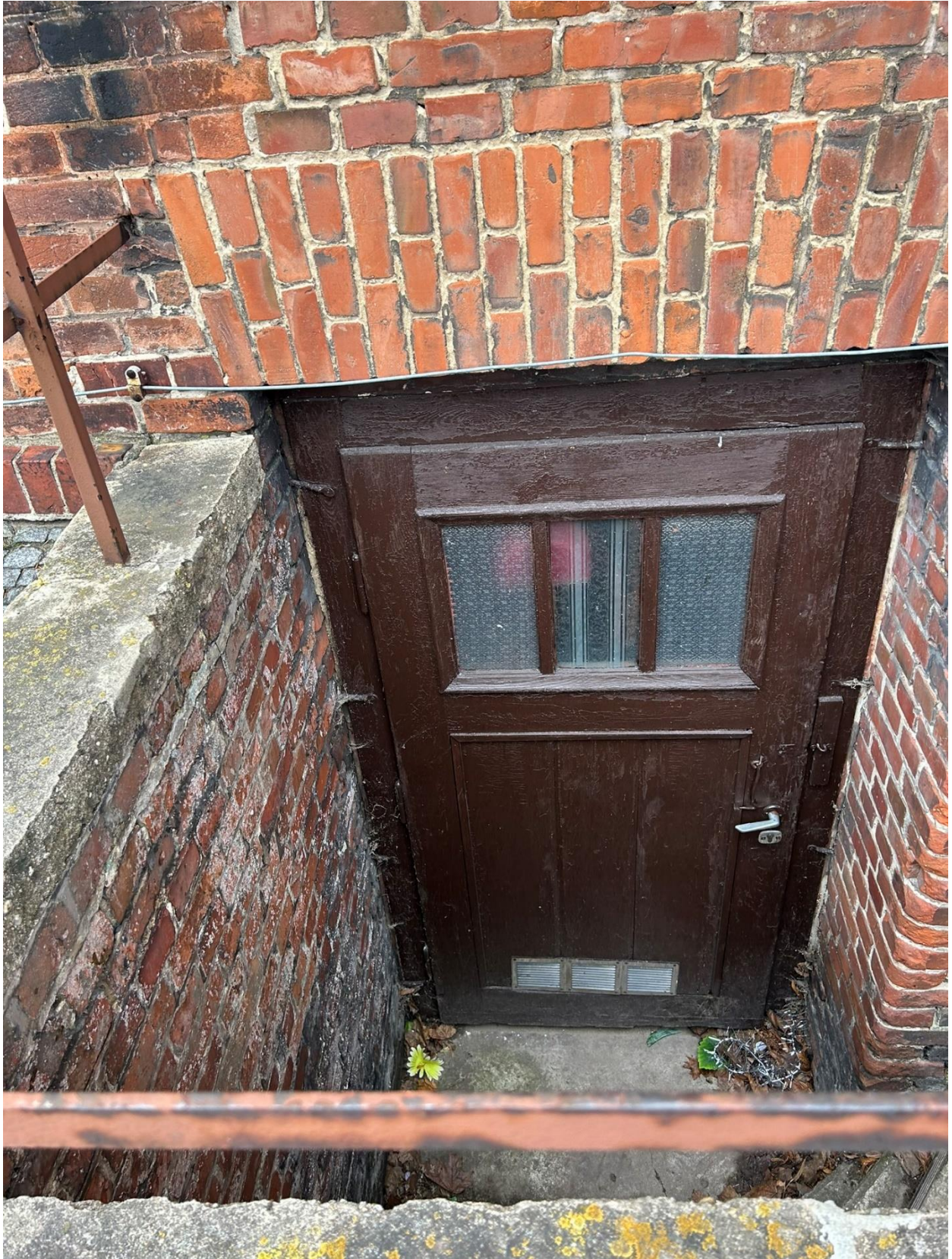
Drzwi do kotłowni(?)
