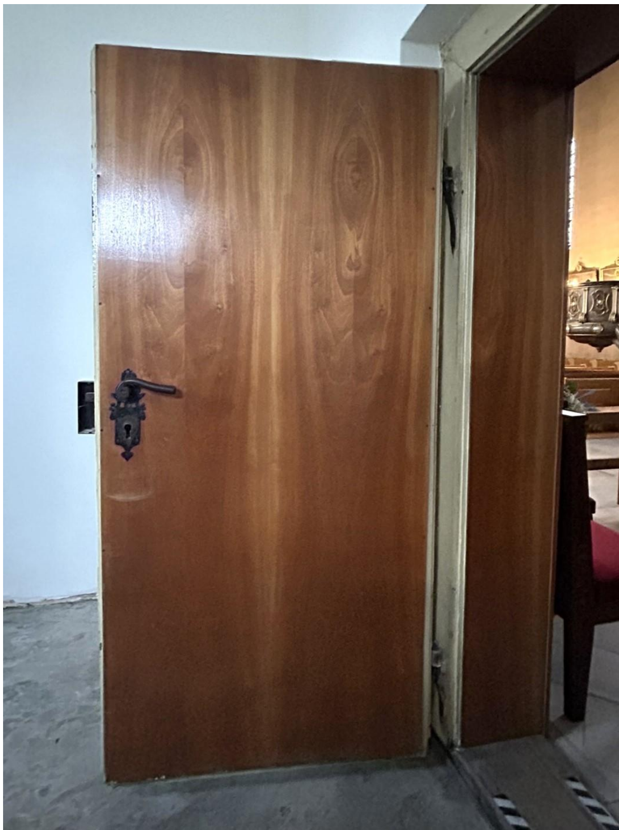
Drzwi do zakrystii- płyta drewnopodobna nabita na skrzydło i framugę
